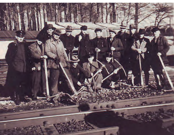
Dieses Bild aus dem Februar 1940 zeigt eine Gleisbaurotte am Bahnhof Varresbeck. Foto: Archiv Dieter Kastel
